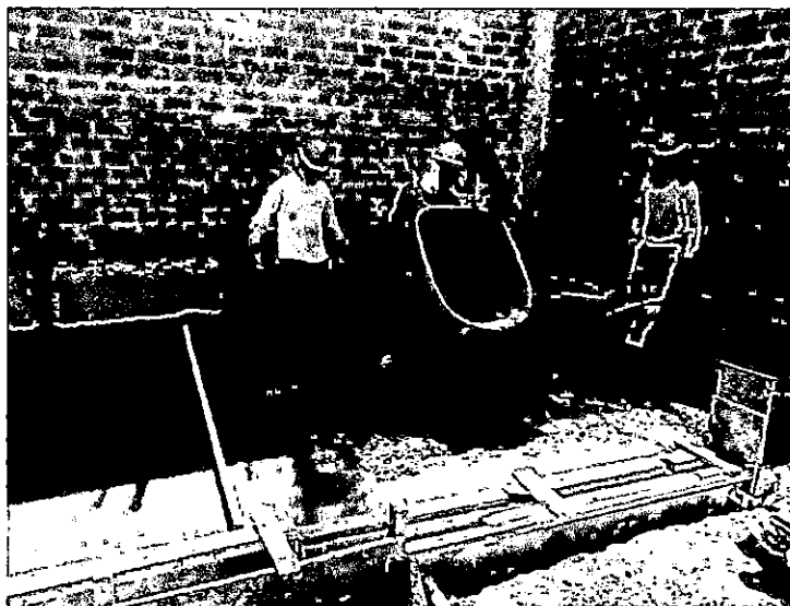
FOTO N°1: Se realizan los trabajos de fundido de concreto, Área de Almacenes.
